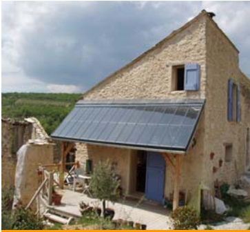
Capteur solaire thermique
