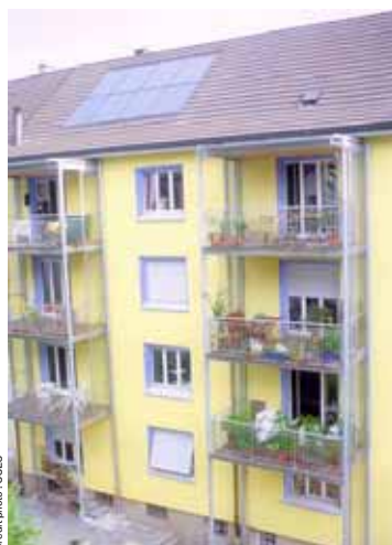
Maison familiale des années 30 rénovée. Système solaire thermique intégré en toiture
