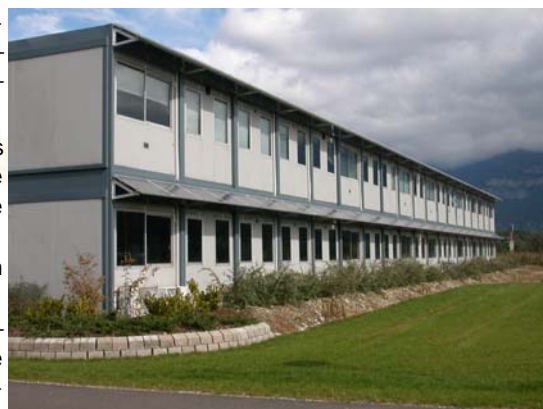
Face sud du bâtiment INES
